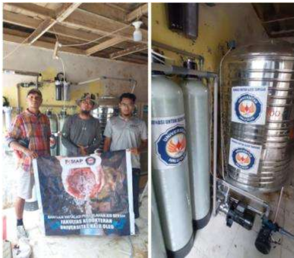
Gambar 3. Pemasangan filter air bersih
