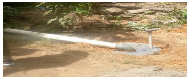
Gambar 9. Kondiri Air Limbah sesudah dilakukan Pembuatan Saluran Pembuangan Air Limbah rumah tangga (SPAL)
