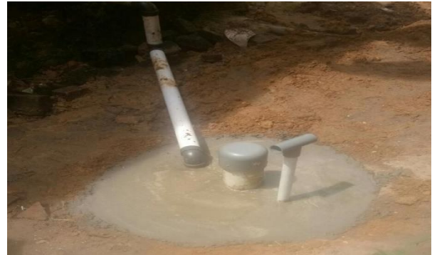
Gambar 7. Kondisi air limbah rumah tangga setelah dilakukan Pembuatan Saluran Pembuangan Air Limbah
