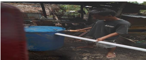
Gambar 4. Membuat Rangkaian Sarana Pembuangan Air Limbah
