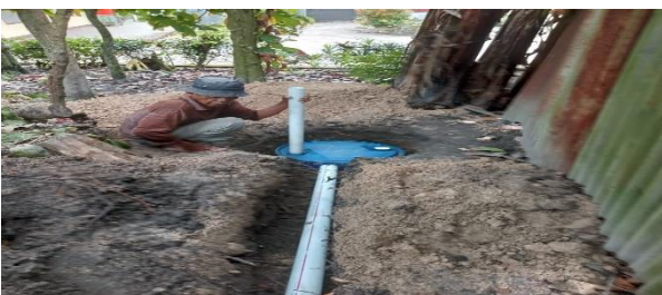
Gambar 5. Perakitan Sarana Pengolahan Air Limbah
